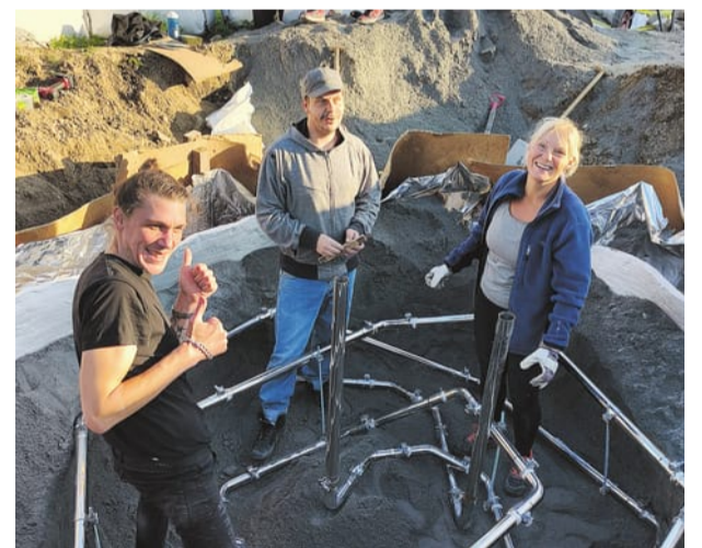
Avgasrör från biltema grävs ner i sand. Tryckfallet har visat sig vara en av utmaningarna.
