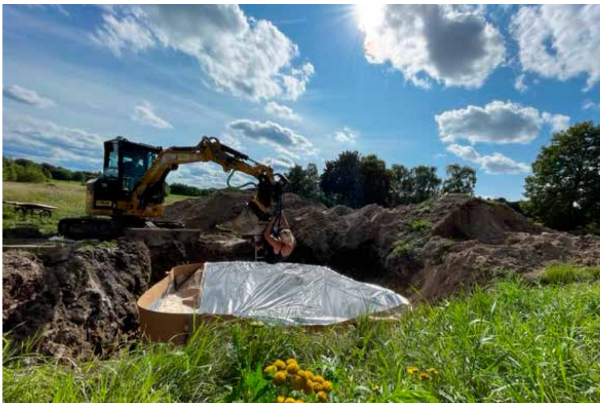
Här är K-mits lager i Hässelby utanför Stockholm fyllt med sand och täckt med aluminiumpapp på ovsidan.
