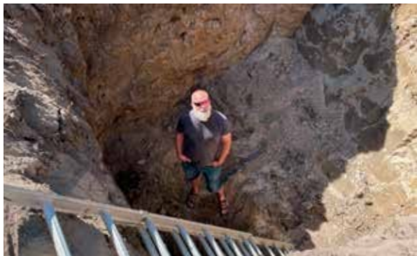
Pontus Kindblad på K-mit i gropen där sandlagret senare installerades.
