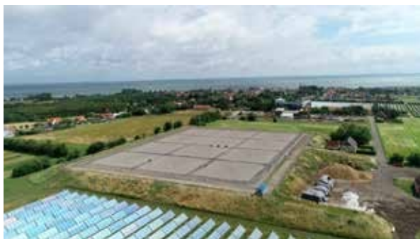
Marstals anläggning kombinerar solfångare och groplager och ligger i södra Danmark, på ön Ærø.
